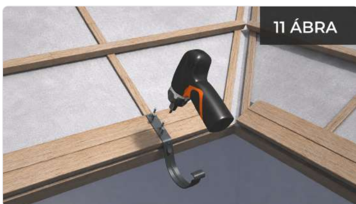
A tartó rögzítése csavarbehajtóval a gyári furatokon át.
