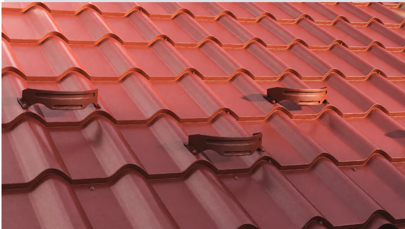
FIG.8 – Hófogó tartók felszerelve a cserepeslemezen
