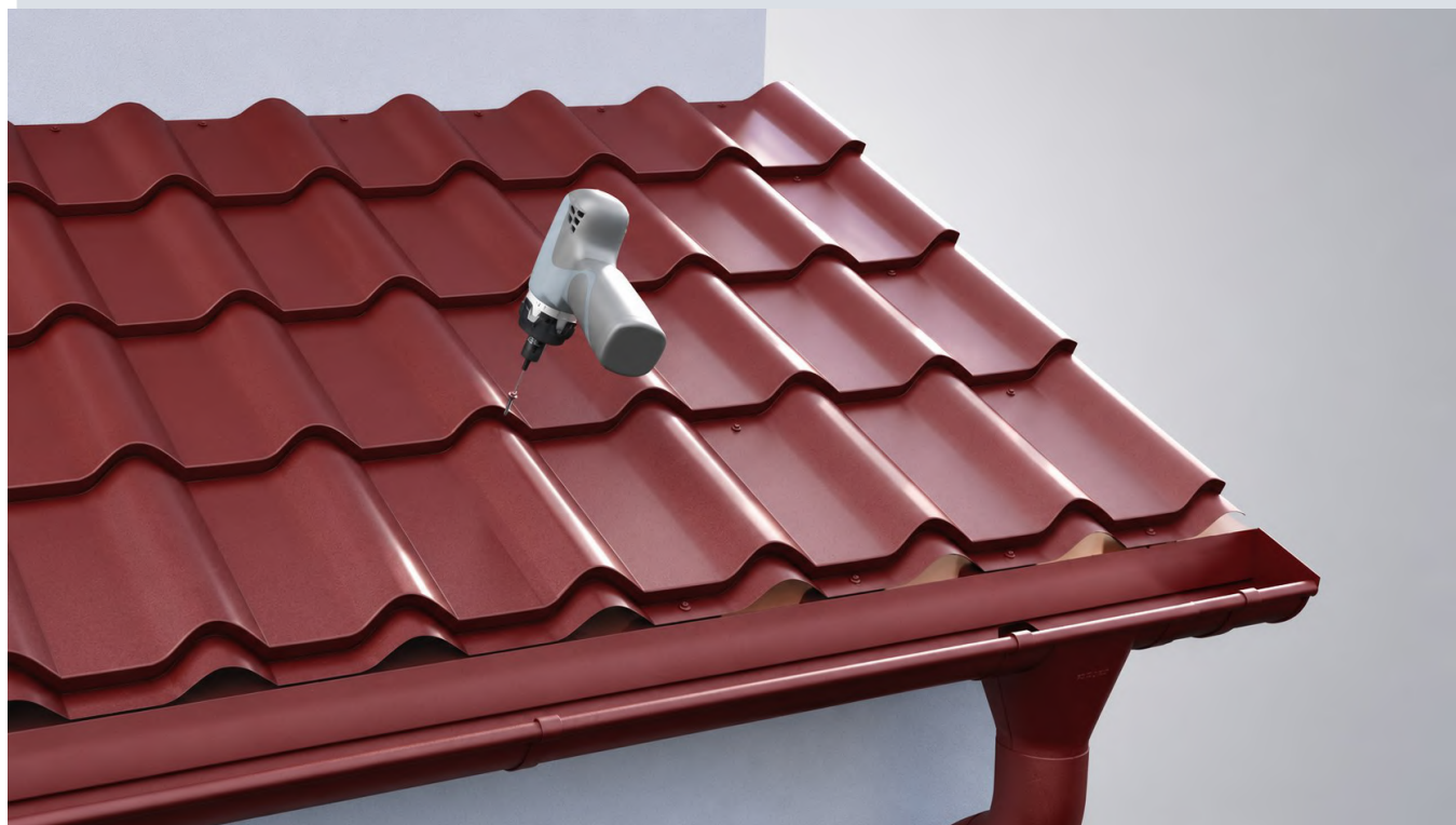
FIG.6 – Önfúró EPDM-tömítő csavar behajtása a hullámvölgybe
